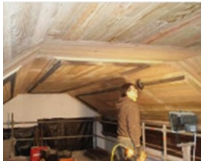
Aspecto geral do tecto durante a fixação de molduras
