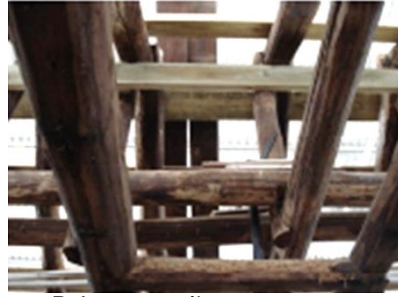
Reforço com tábuas na zona de ligação dos prumos
