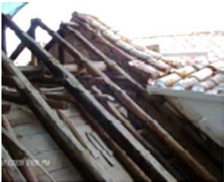
Nave Central - pormenor das varas originais antes da intervenção
