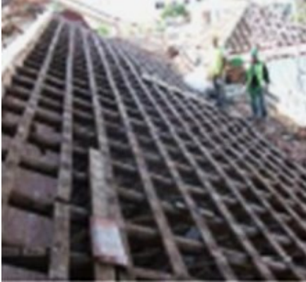
Aspecto das disposições dos vários elementos que compõem a estrutura da cobertura
